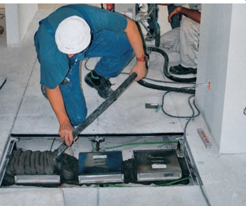
Das Thema „Brandschutz“ wird immer wichtiger. Hier wird gerade ein Verteilerschacht verfüllt.
