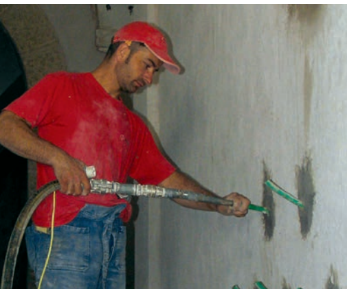
Der Sprayboy beim Injizieren von Mörtel in Bohrlöcher.
